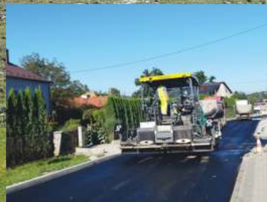
Nowa droga przez Trzciang
