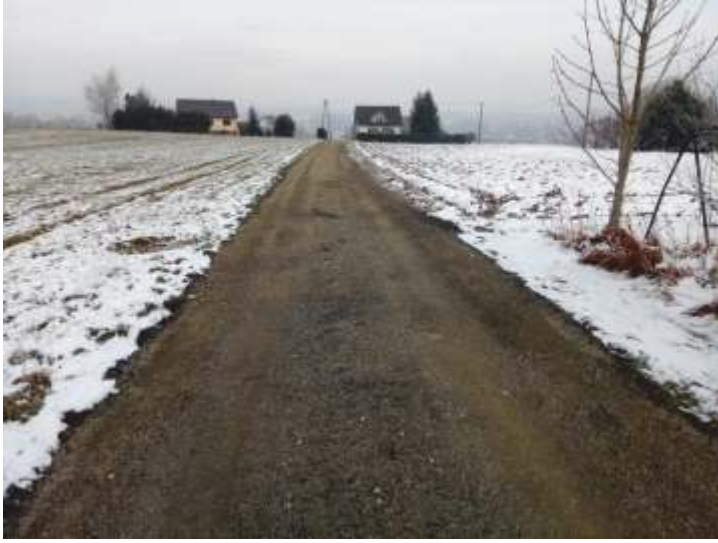
Remont drogi Ujazd - Biros
