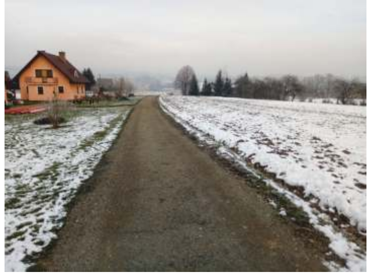
Remont drogi Ujazd - Le niak
