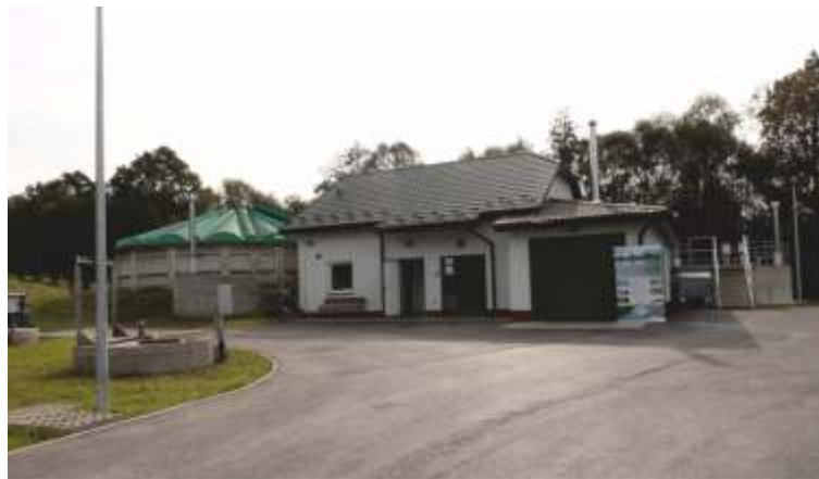
Rozbudowa oczyszczalni ścieków
