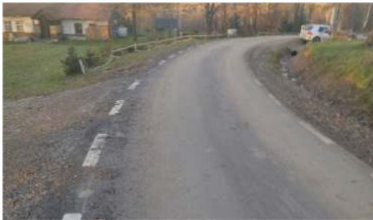
Budowa drogi gminnej Kamionna – Rola II
