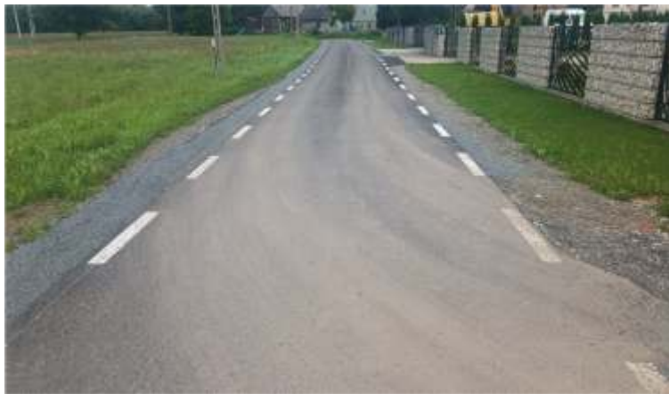
Budowa drogi gminnej Trzciana -Zarzeczce
