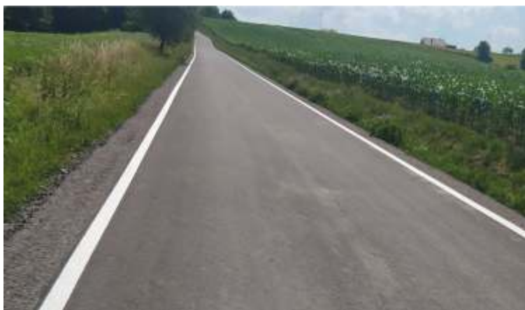
Budowa drogi gminnej Łąka Dolna – Półrolki
