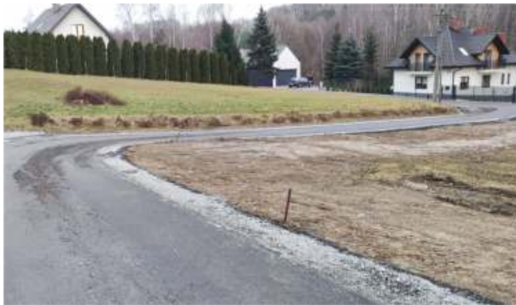
Budowa drogi gminnej Trzciana dr. wew. 978/5
