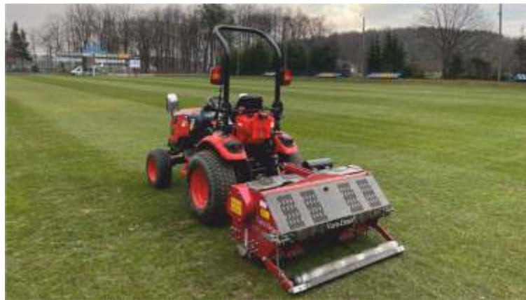
Prace związane z modernizacją płyty głównej na boisku w Rdzawie
