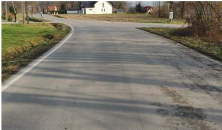
Budowa drogi gminnej Rdzawa Centrum wsi
