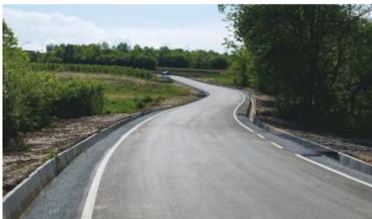
Budowa drogi gminnej Leszczyna Pod Klubę
