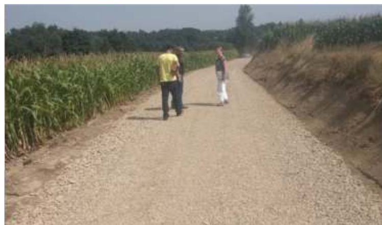
Budowa drogi gminnej Trzciana -Wołowiec
