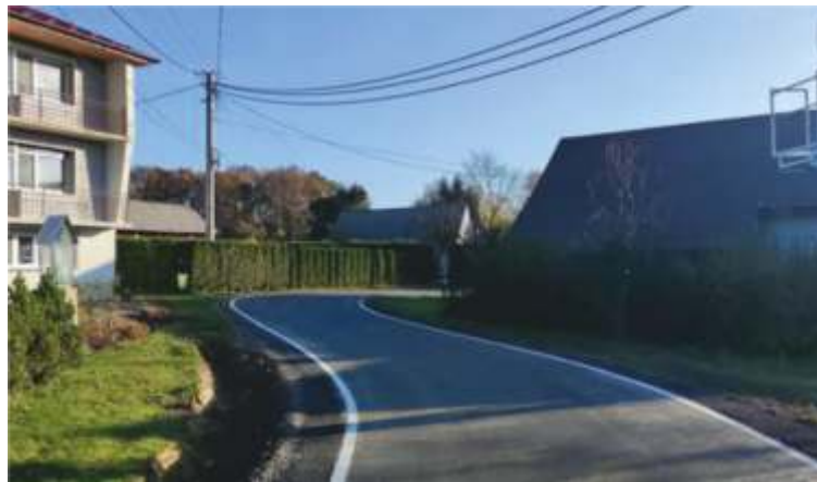
Budowa drogi gminnej drogi Łąka Dolna – Pączek
