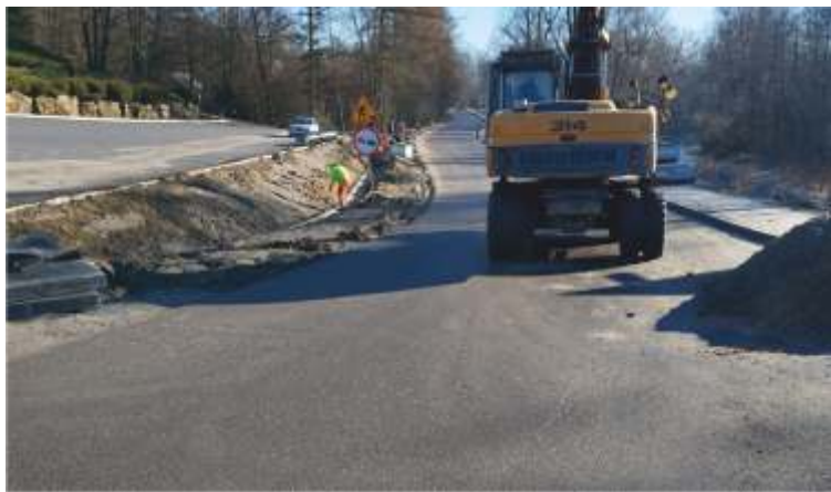
Przebudowa Drogi Powiatowej w Łąckie Dolnej – Pasternik wkład Samorządu Powiatu i Gminy.
