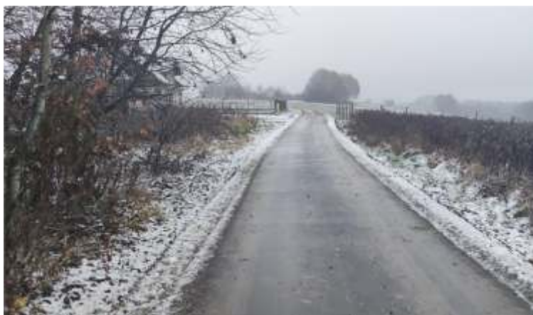
Budowa drogi gminnej Łąka Dolna – Zadziele
