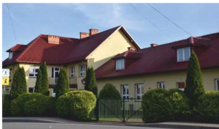
Malowanie dachu Szkoły Podstawowej w Łąckie Dolne
