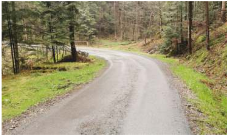
Budowa drogi gminnej Kamionna PACEK
