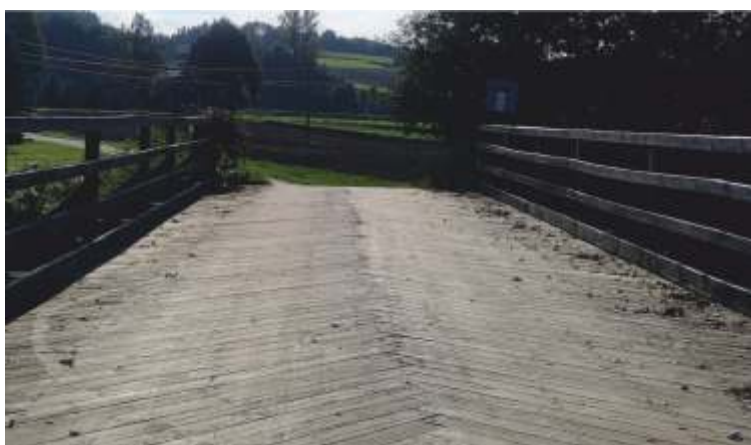
Modernizacja mostu Łąka Dolna Pasternik
