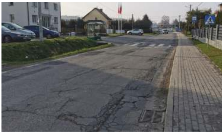
Rusza Przebudowa Drogi Powiatowej w Trzcinie Centrum (Dotacja Starostwa).
