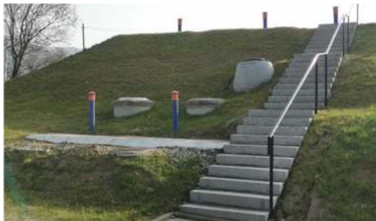
Rozbudowa zbiorników na wodę pitną
