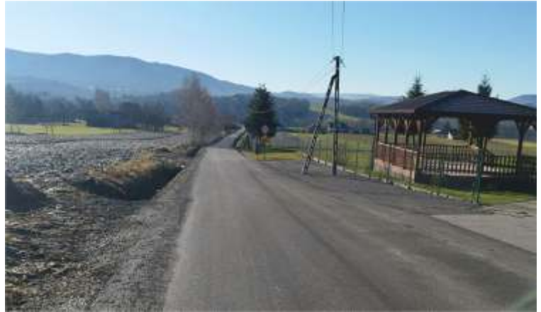
Budowa drogi gminnej w Kierlikówce koło Szkoły wraz z budową parkingu
