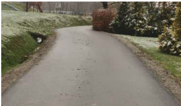
Budowa drogi gminnej Kamionna NAD KRÓLEM
