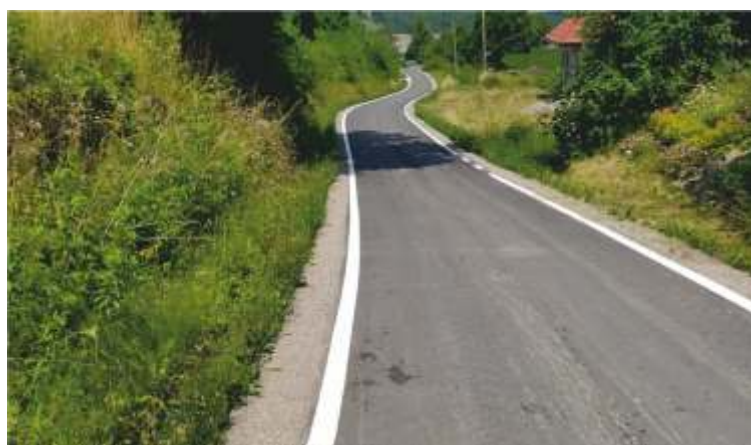
Budowa drogi gminnej Kamionna – Polityczna
