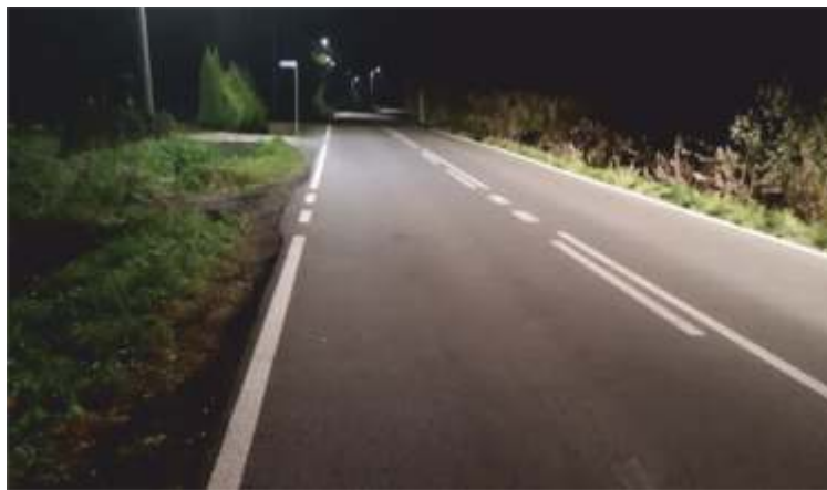
Nowe oświetlenie uliczne w Kierlikówce
