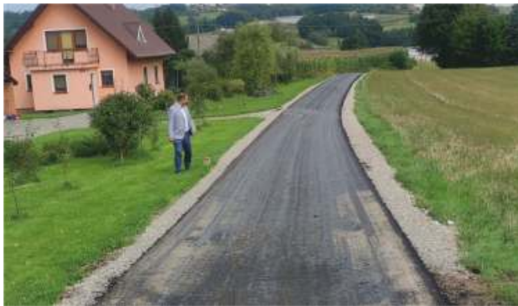
Budowa drogi gminnej Ujazd-Leśniak
