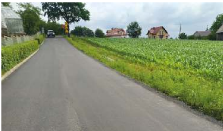
Budowa drogi gminnej Trzciana – Srokówka
