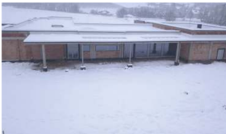
Budowa nowego przedszkola i żłobka w Trzcianie
