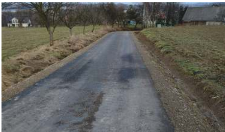
Budowa drogi gminnej Ujazd – Nycz
