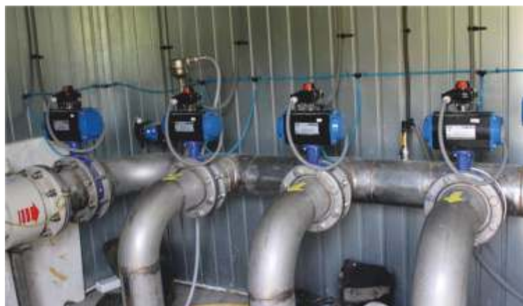
Rozbudowa ujęcia wody w trakcie realizacji
