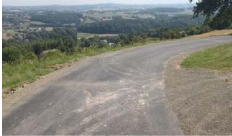
Budowa drogi gminnej Rdzawa- Góry
