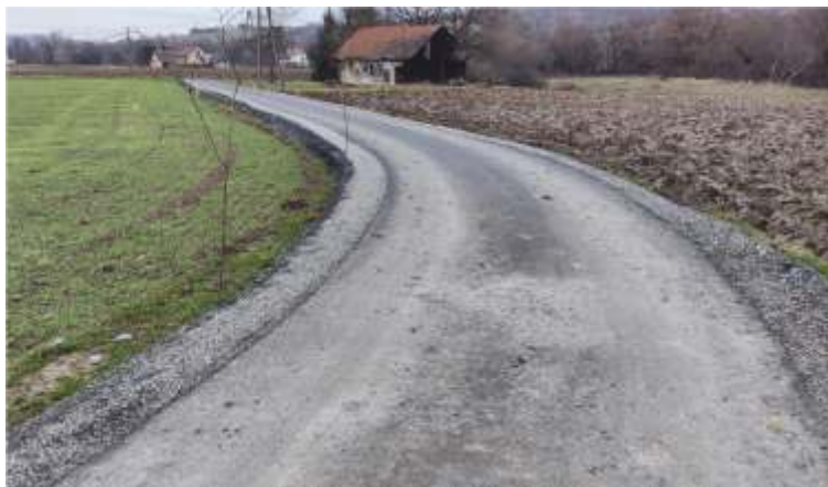
Budowa drogi gminnej Trzciana GUMULIŃSKI
