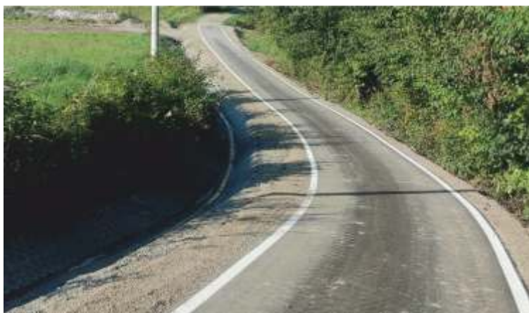
Budowa drogi gminnej Łąka Dolna Babral
