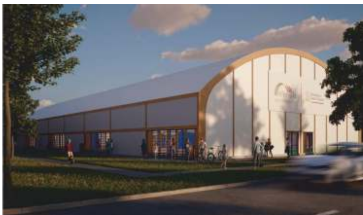
Dotacja na budowę Olimpij w Trzcianie
