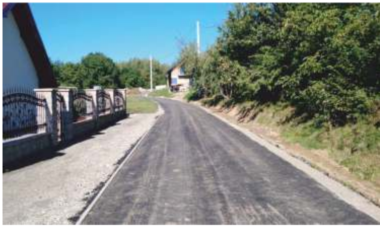
Budowa drogi gminnej Leszczyna – Kalisówka
