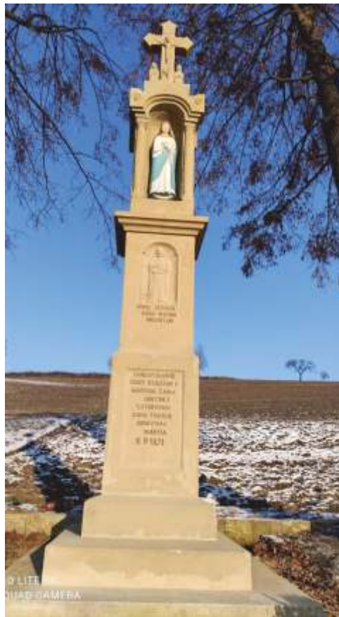
Remont Kapliczki na działce Państwa Dudziaków z 1891 r. w Kamionnej
