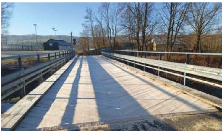
Modernizacja mostu Trzciana Orlik
