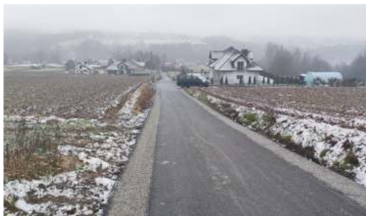
Budowa drogi gminnej Łąka Dolna KOŁO DUDKA
