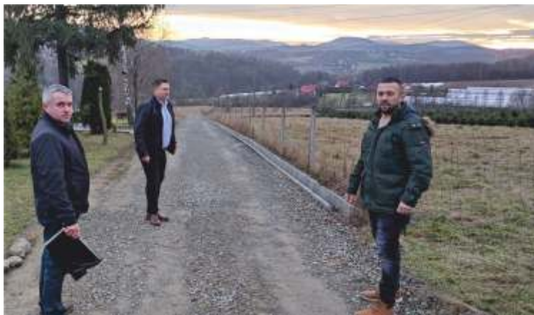
Budowa drogi gminnej Trzciana SZARAJ
