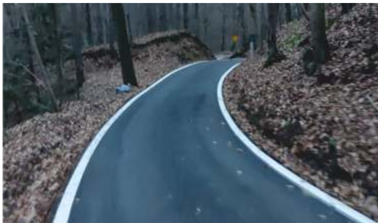
Budowa drogi gminnej Kamionna BRZEG
