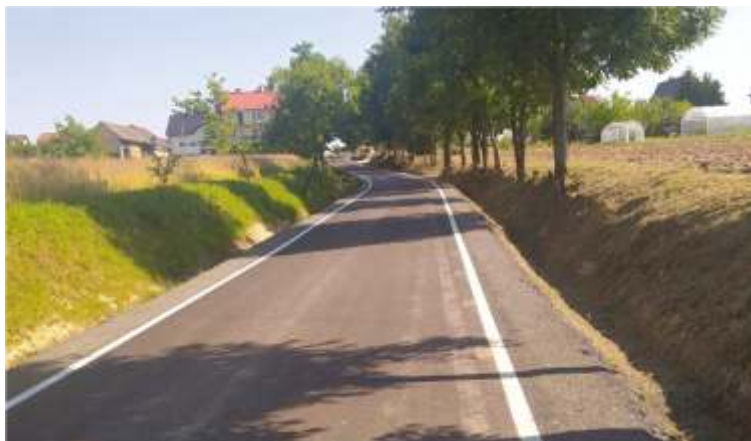
Budowa drogi gminnej w Kierlikówce, od drogi powiatowej w kierunku Kościoła
