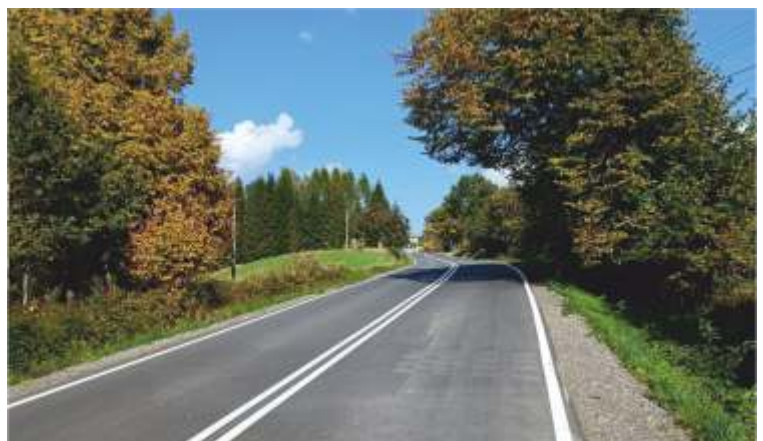
Budowa Drogi Powiatowej Ujazd - Rdzawa - Kamionna (dotacja Starostwa)
