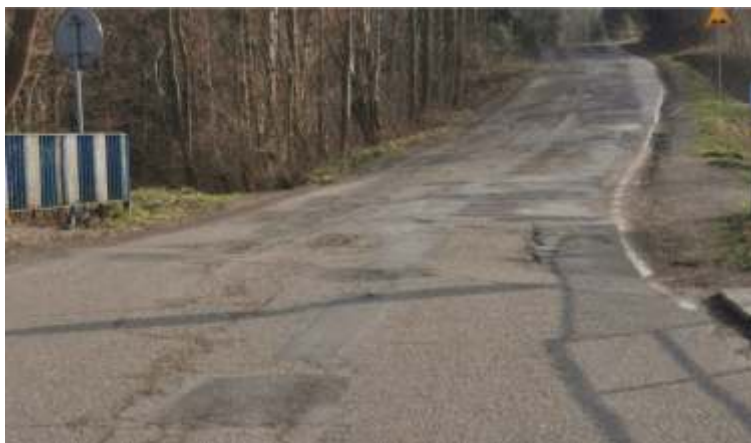
Rusza Przebudowa Drogi Powiatowej w Kamionnej wkład Samorządu Powiatu i Gminy.
