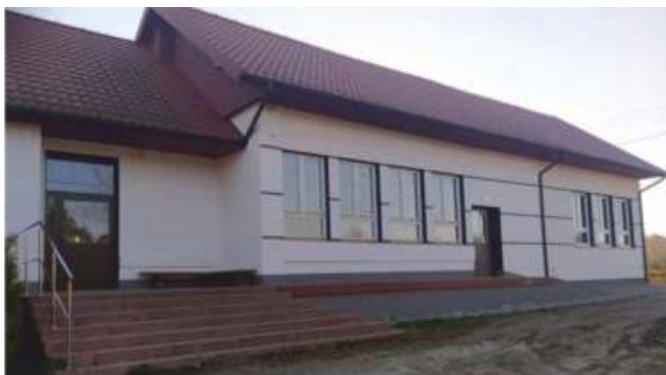
Rozbudowa świetlicy w Kamionnej wraz z nową kuchnią i wyposażeniem
