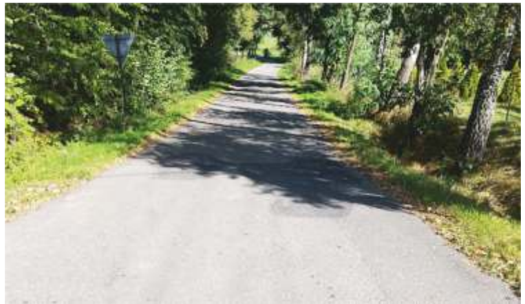
Budowa drogi gminnej gminnej Kierlikówka pod Kościół
