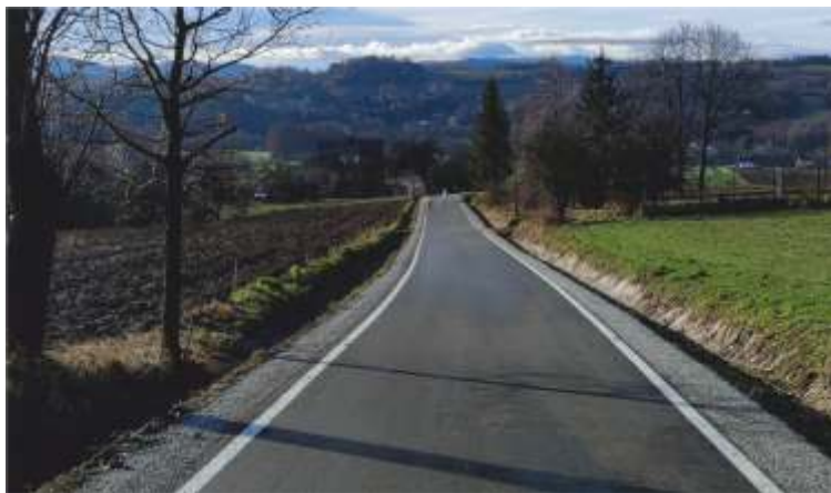
Budowa drogi gminnej Ujazd - Waligóra
