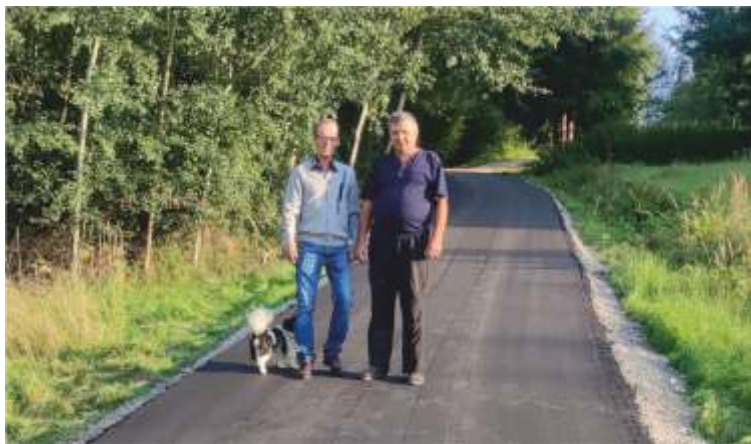
Budowa drogi gminnej Ujazd - Marzec
