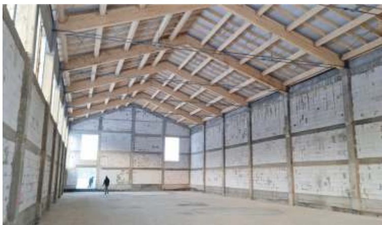
Budowa sali gimnastycznej w Łąckiej Dolnej
