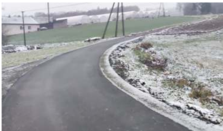
Budowa drogi gminnej Łąka Dolna JAGIELSKI
