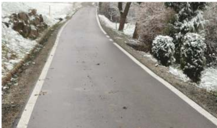
Budowa drogi gminnej Kamionna LAS
