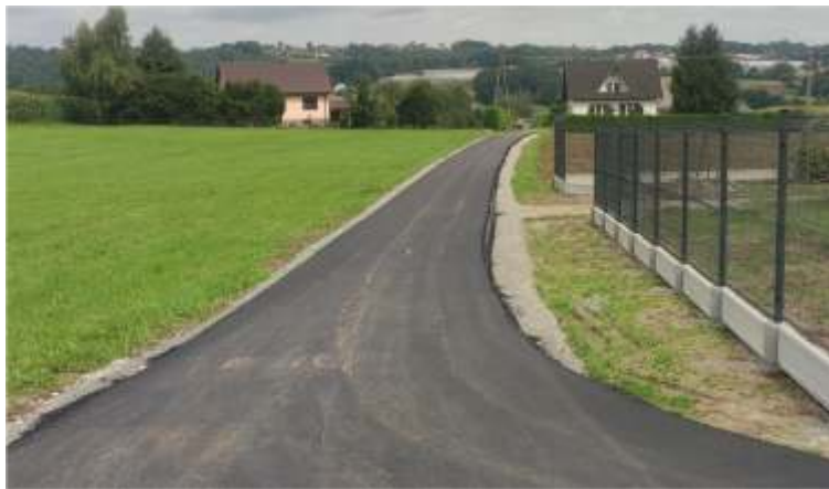
Budowa drogi gminnej Ujazd- Biros
