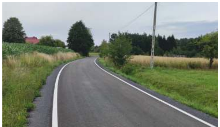
Budowa drogi gminnej Kierlikówka do Stokłosy
