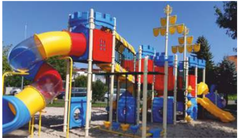
Budowa placu zabaw w Kierlikówce
