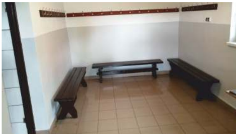
Remont szatni Klubu Sportowego Trzciana 2000
