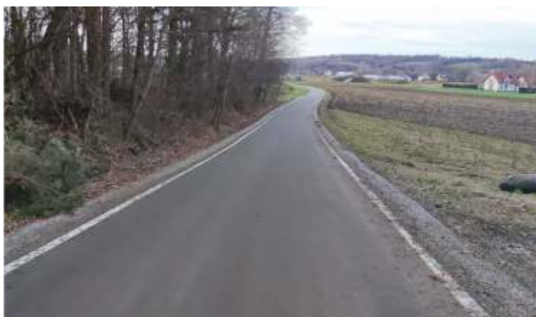
Budowa drogi gminnej Rdzawa – Kierlikówka
