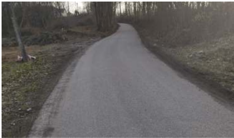
Budowa drogi gminnej Ujazd – Zyznówka.
