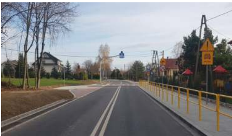
Budowa Drogi Powiatowej w Kierlikówce wkład Samorządu Powiatu i Gminy
