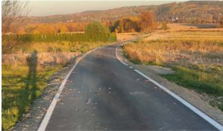
Budowa drogi gminnej Leszczyna Popówki
