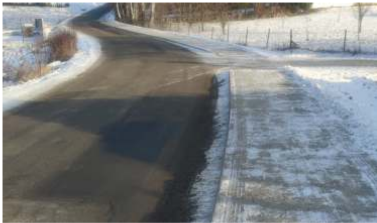
Budowa chodnika przy drodze Powiatowej w Leszczynie (budżet gminy).
