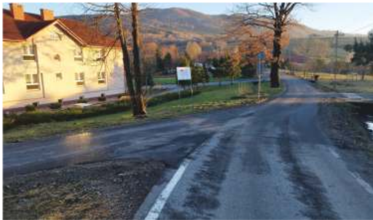
Budowa drogi gminnej Kamionna – pod Dwór wraz z budową parkingu przy szkole
