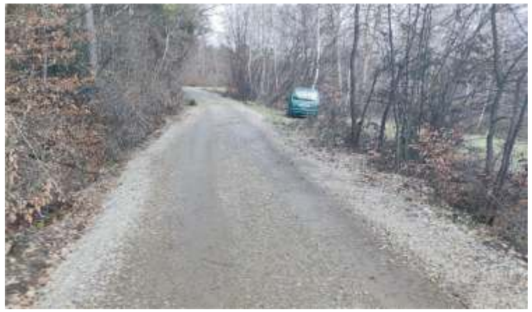
Budowa drogi gminnej Leszczyna WICHRARZ
