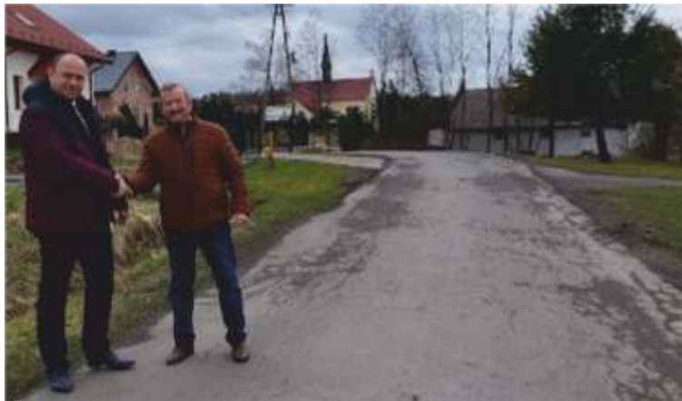
Budowa drogi gminnej Kierlikówka-Rdzawa I
